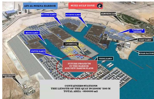
Figure11 – Al Ain Al Sokna Harbour
